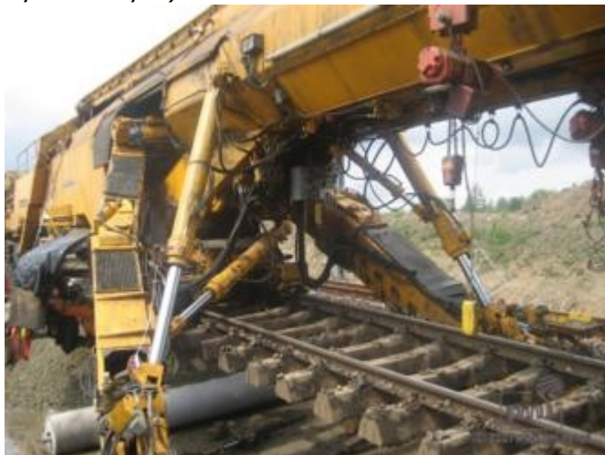
1. Modernizacja linii Skierniewice-Koluszki wykonywana przez PNI w 2007. Źródło: pni.net.pl
