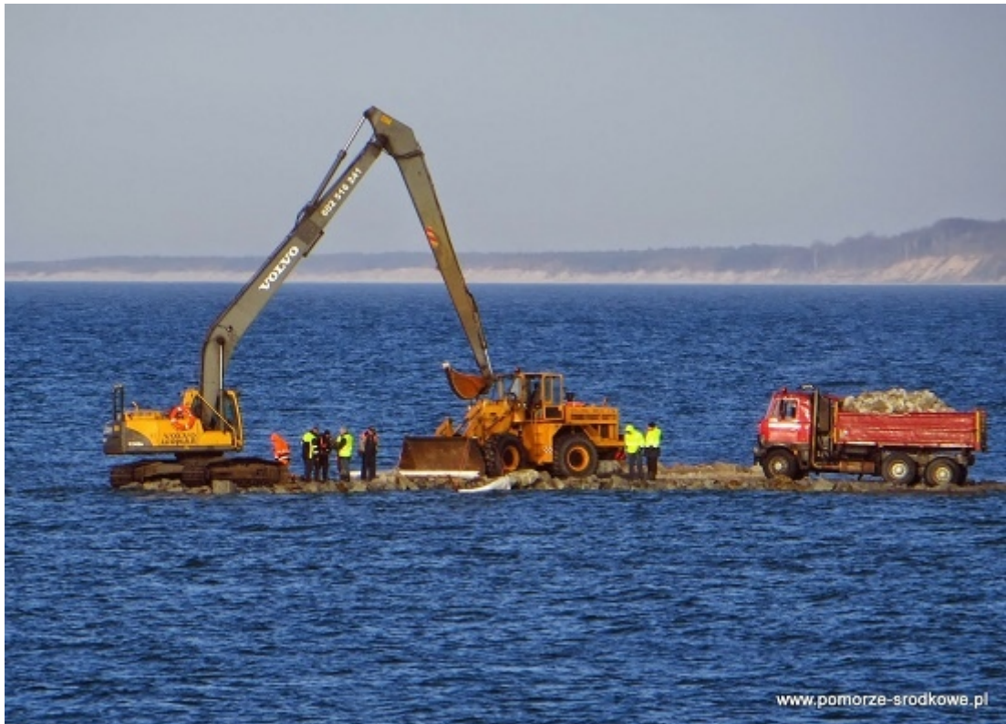
Budowa sztucznej rafy w Ustce, źródło: pomorze-srodkowe.pl ( http://pomorze-srodkowe.pl )
